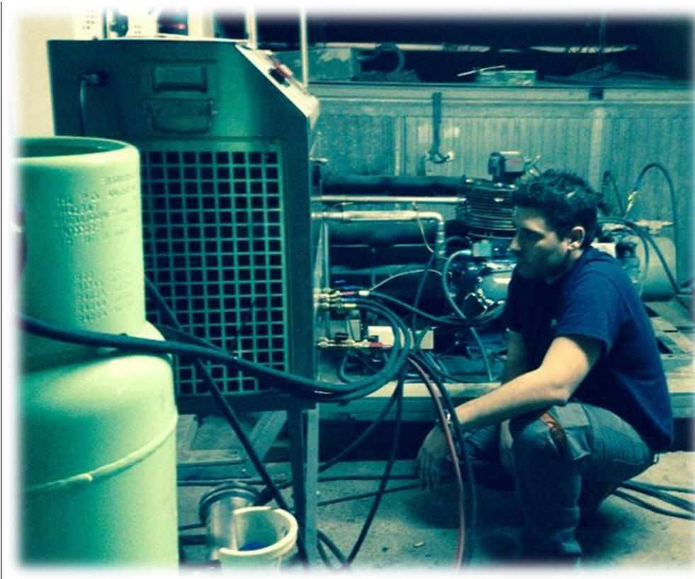
**Foto1-limpieza del circuito frigorífico con FRI3OILSYSTEM**
